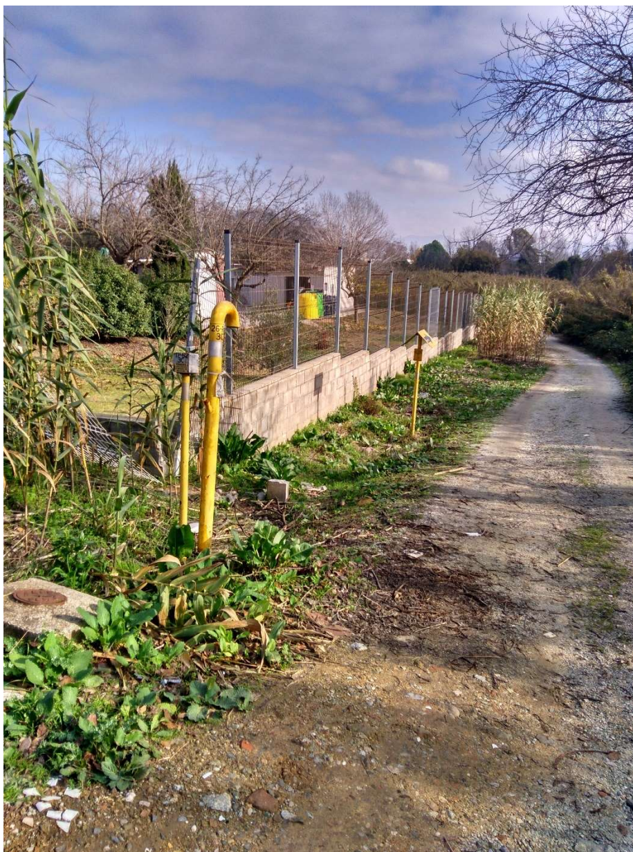
Espai de protecció infraestructura gasoducte - Camí
