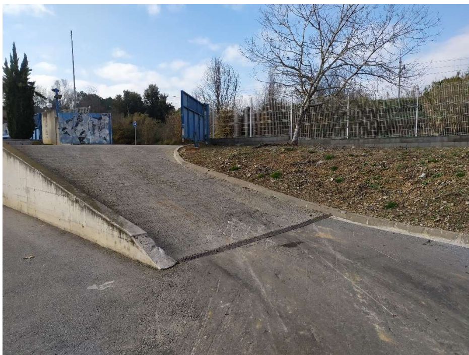
Rampa d'accés de camions
