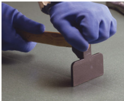
Masaje sobre la junta del pavimento
