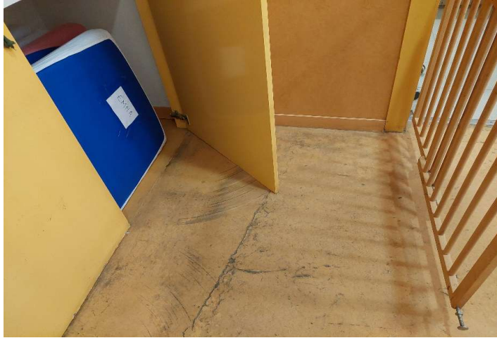
Interior d'armari (no hi ha arrambador)
