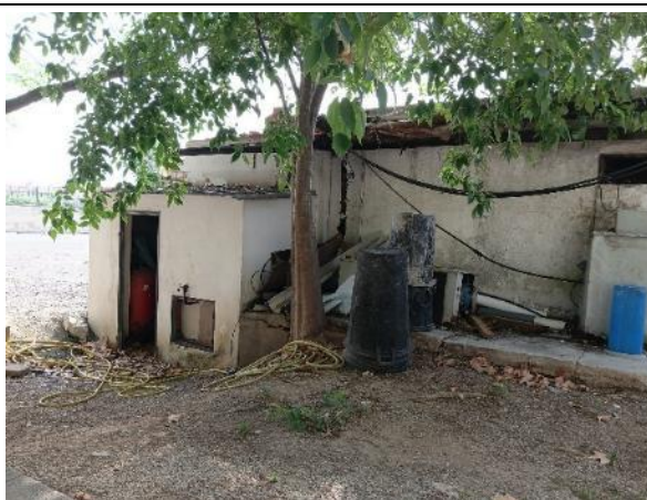
Edificios y cubiertos de la zona de acceso.
