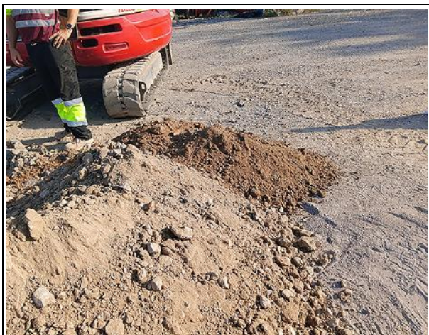
C2 Acopios Relleno
