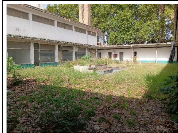
Zona de acceso (parcela #4). Cubiertos y edificios cercanos a la antigua chimenea.
