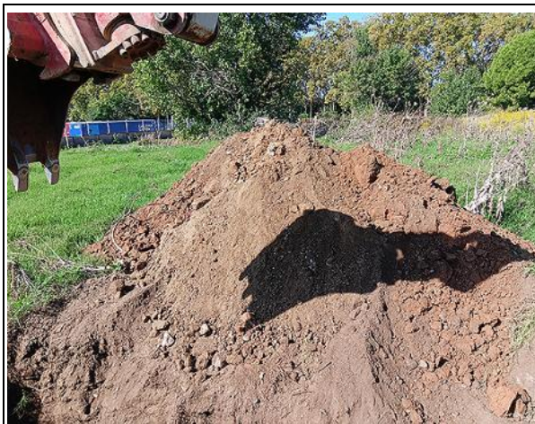
C3 Acopio Relleno
