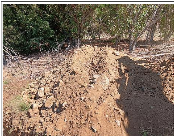
C5 Acopio Relleno
