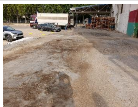
Salida sur de la nave. Cubierto con palés.
