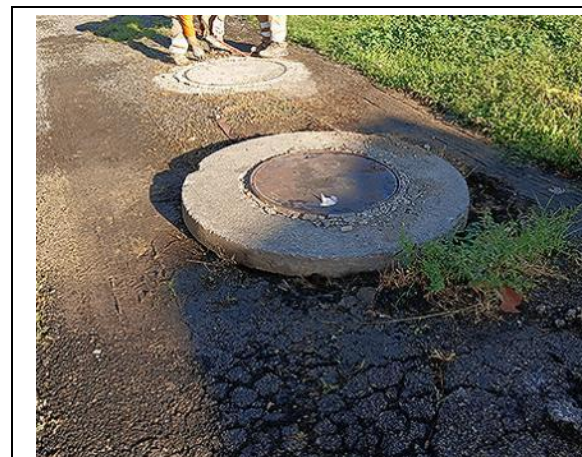
Arquetas en la zona de acceso (parcela #4).
