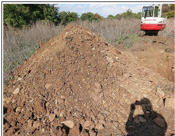
C8 Acopio Relleno Marrón
