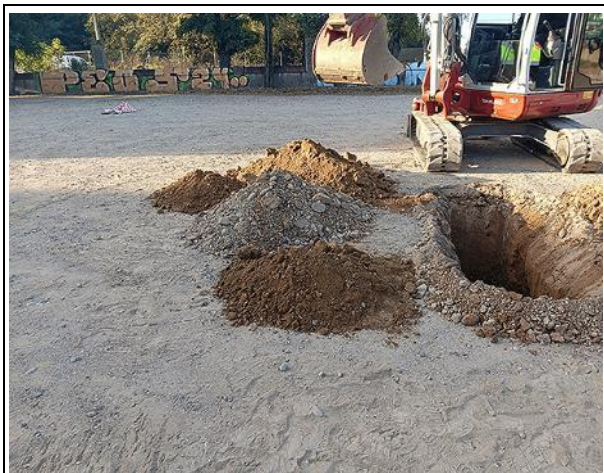
C1 Acopios Relleno
