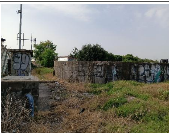
Parcela #1. Pozo y depósito circular
