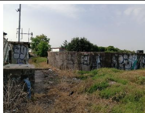
Parcela #1. Pozo y depósito circular
