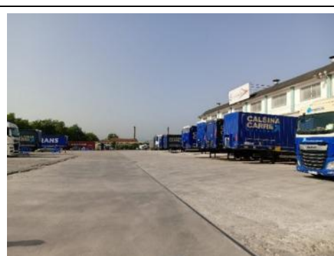
Zona exterior pavimentada.
