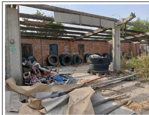
Restos de chatarra y residuos en los cubiertos.
