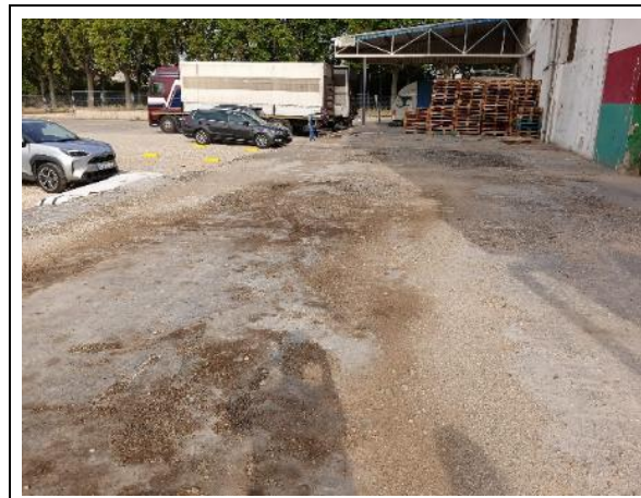
Salida sur de la nave. Cubierto con palés. (parcela #4)
