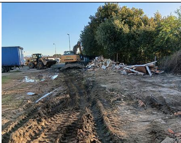
Derribo de los cubiertos (parcela #4).
