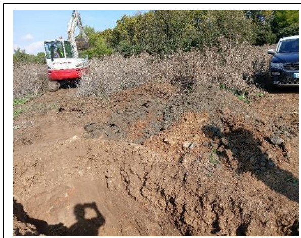
C8 Acopio Relleno Grisáceo
