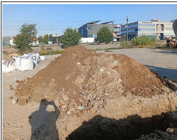
C2 Acopios Relleno
