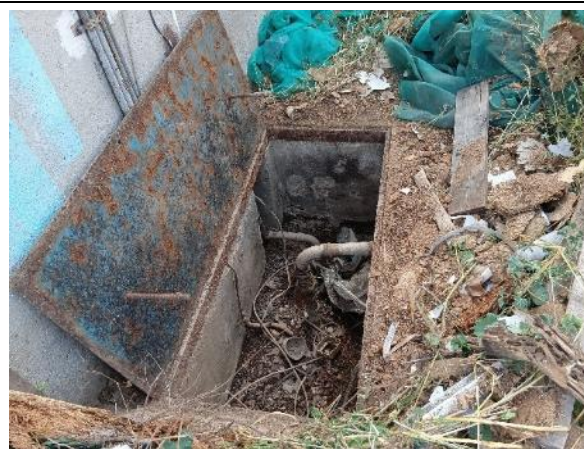
Arqueta posiblemente asociada al antiguo depósito enterrado. Zona de cubiertos.
