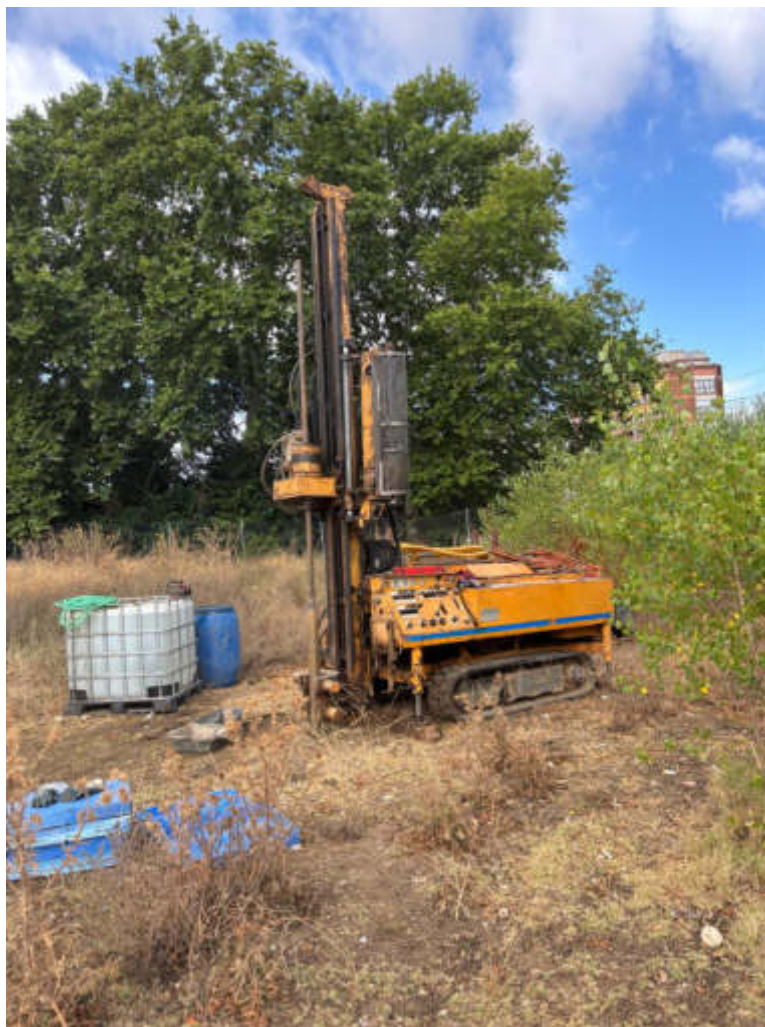
Fotografia 7. Execució sondeig S-2R.
