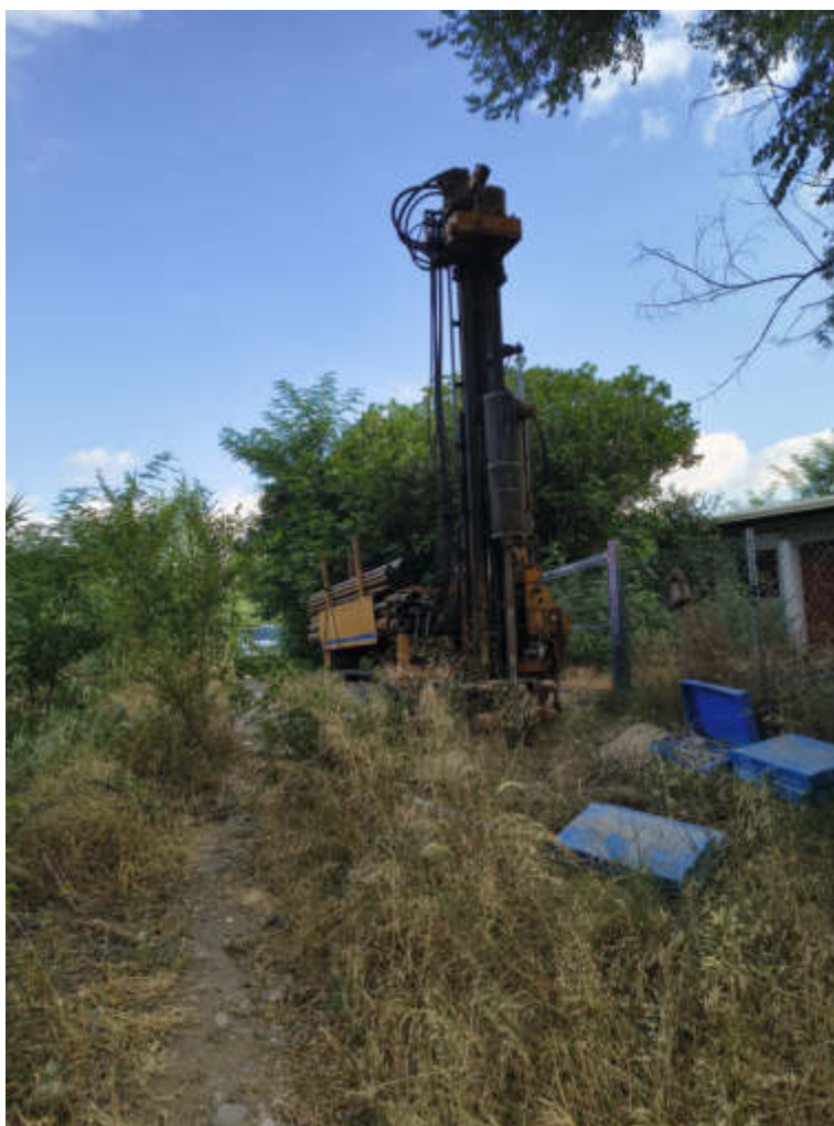
Fotografia 7. Execució sondeig S-1R.
