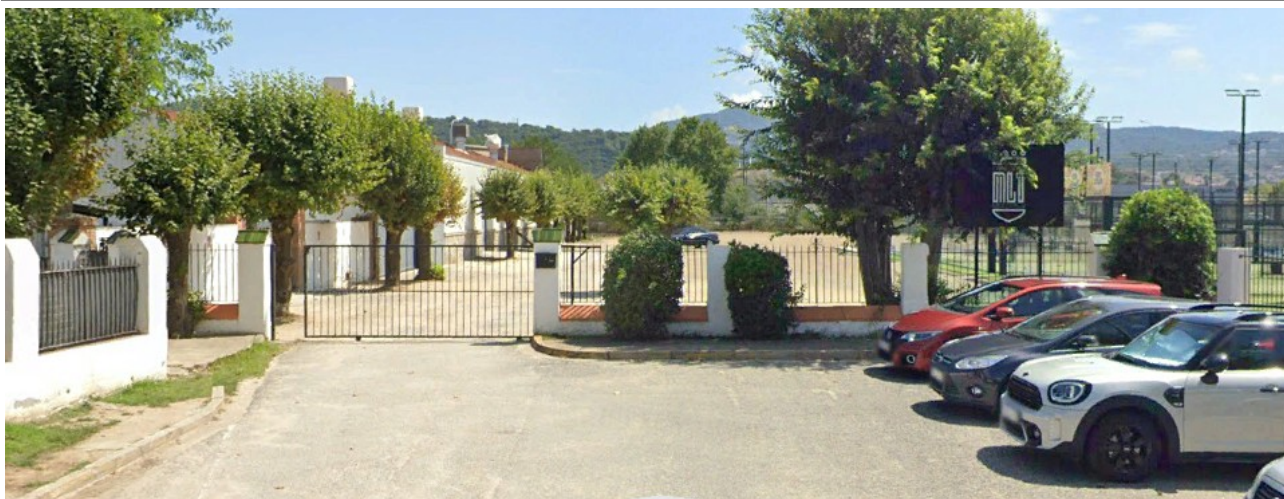
Tanca afectada per les obres de la finca del pàdel
