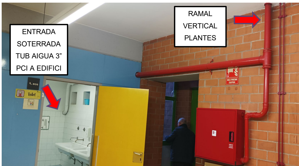
Imatge 10: Ramal-1 vertical accés plantes
