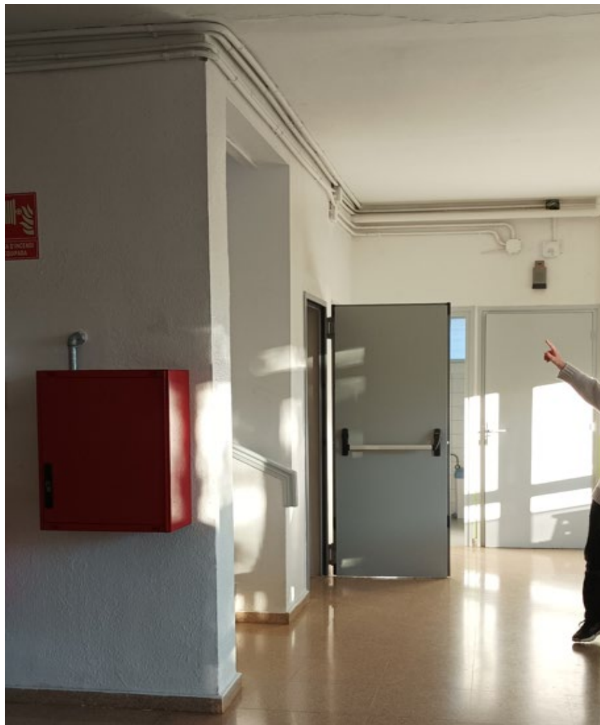
Imatge 10: Primer BIE connectat en planta baixa
