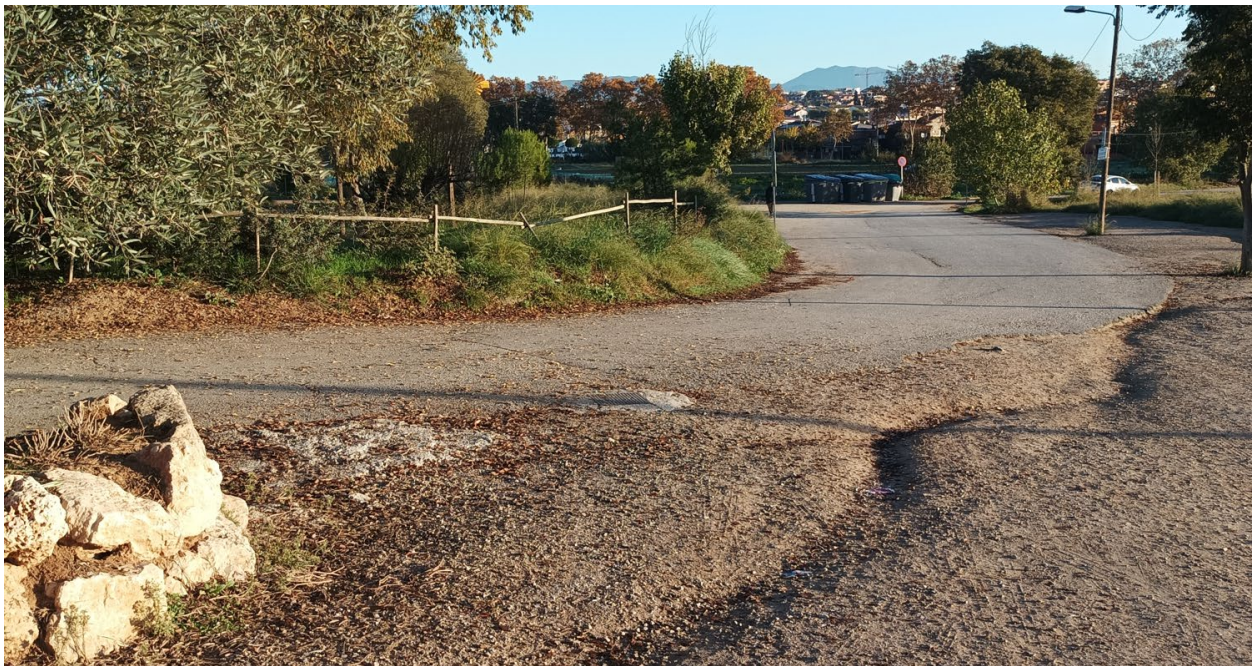
Imatge 1: Perico registrable entrada aigua a l'edifici
