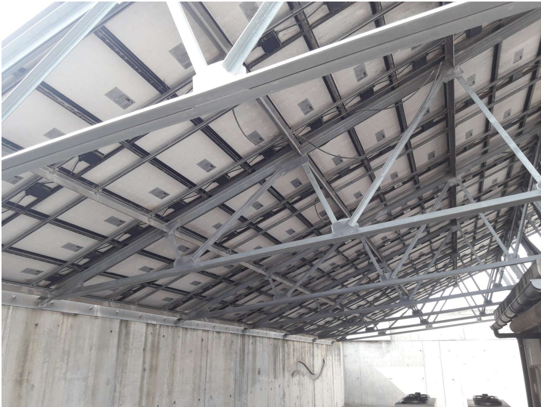
Imatge 2: Estructura amb instal·lació fotovoltaica existent a la coberta de l'edifici administratiu
