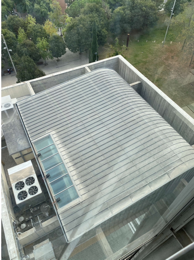
Imatge 9: Coberta de junta alçada de l'edifici institucional
