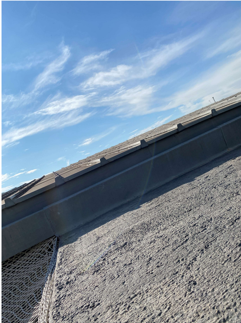
Imatge 10: Coberta de junta alçada de l'edifici institucional
