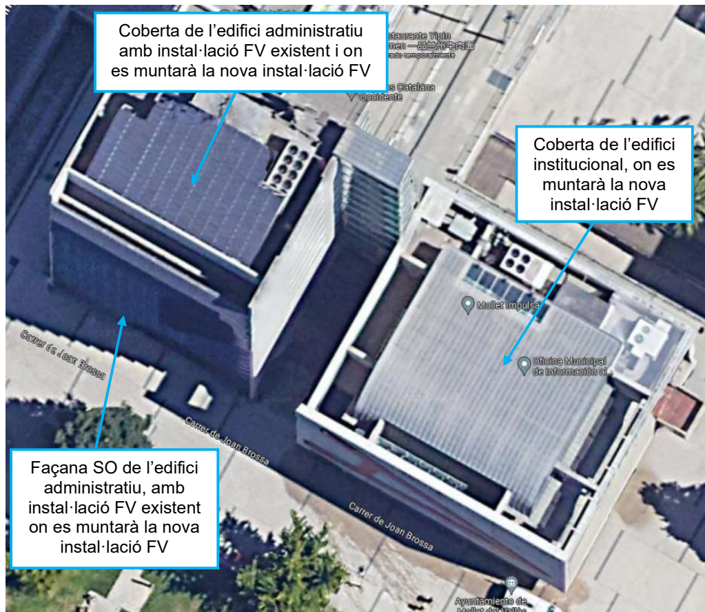
Imatge 2.1. Fotografia aèria de la Casa Consistorial de Mollet del Vallès
