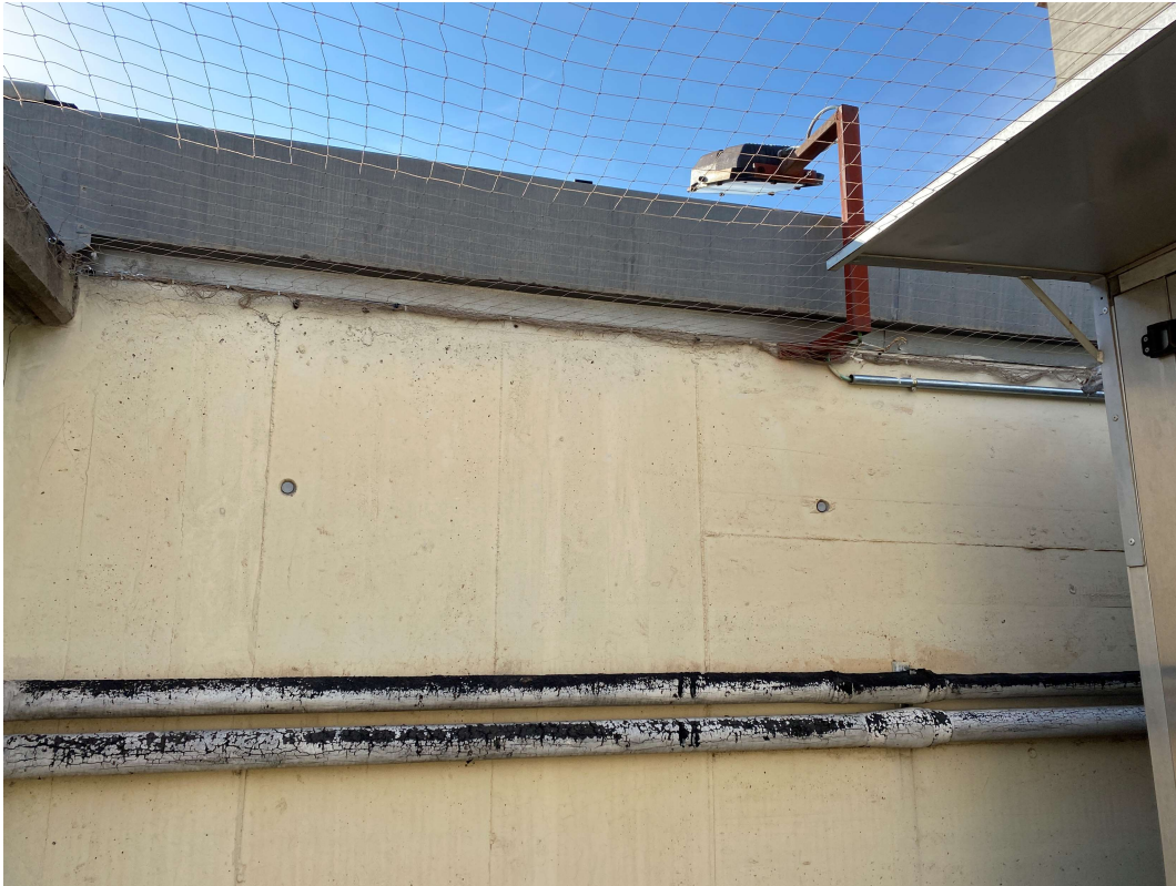
Imatge 11: Paret exterior a la coberta de l'edifici institucional, on es col·locaran els inversors i els quadres de proteccions DC i AC
