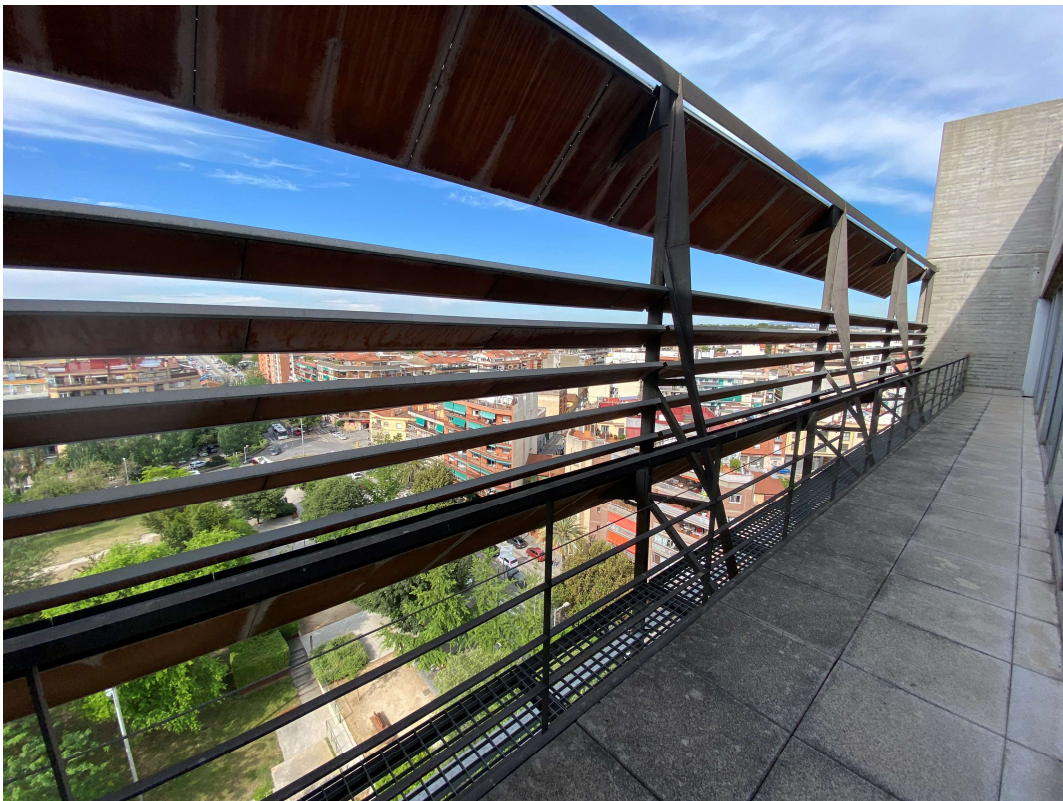
Imatge 8: Façana sud-oest de l'edifici administratiu amb mòduls fotovoltaics a substituir
