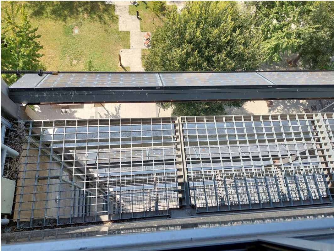
Imatge 7: Façana sud-oest de l'edifici administratiu amb mòduls fotovoltaics a substituir
