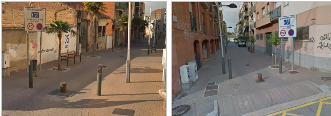
Figura 30: Piló mòbil a la intersecció dels carrers de Portugal i del Sol (esquerra) i piló mòbil a la intersecció dels carrers de Bartomeu Robert i del Sol (dreta).
