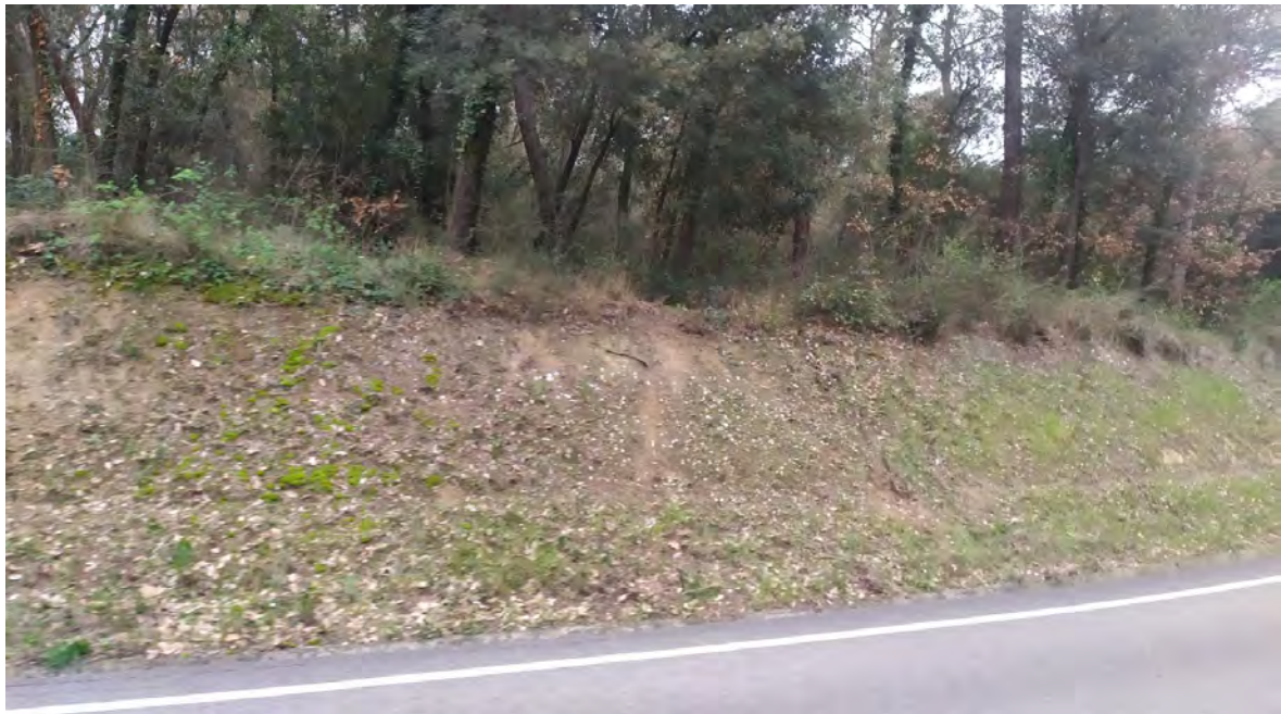
Foto 1. Talussos de la carretera C-155.
