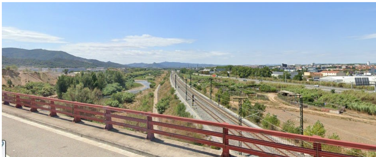
Riu Besòs en el pont de la B-500 i en el pont del Camí de Can Prat
