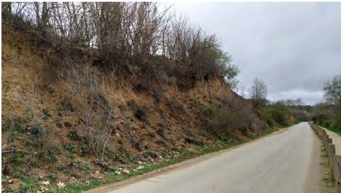
Foto 7. Talussos del camí dels Gallecs, amb indicis d'esllavissades.
