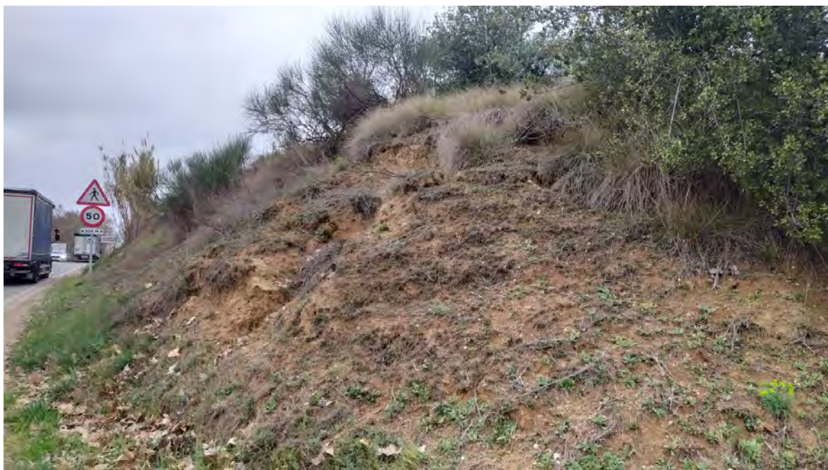
Foto 11. Eslavissada (M1) a la ronda dels Pinetons
