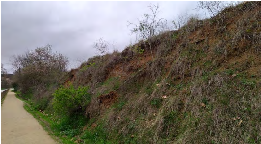
Figura 18. Indicis de lliscaments al camí dels Gallecs
