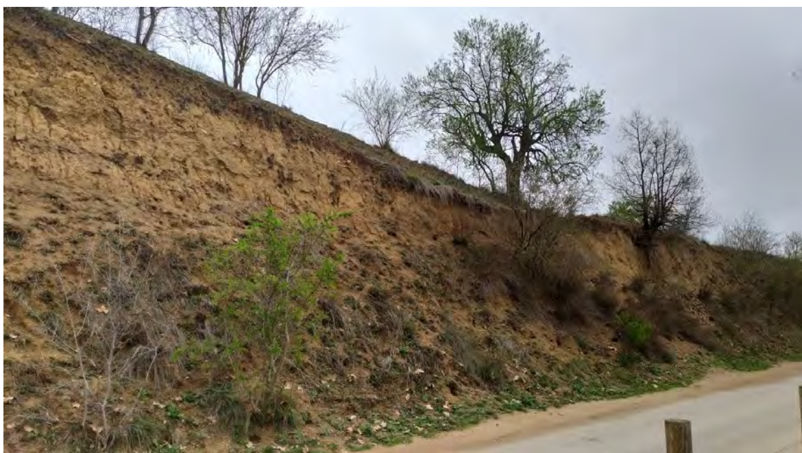
Foto 8. Talussos del camí dels Gallecs, amb indicis d'esllavissades.
