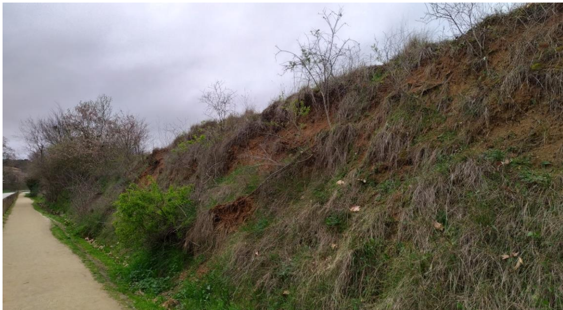
Figura 18. Indicis de lliscaments al camí dels Gallecs
