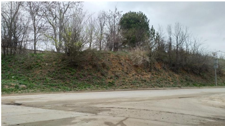
Figura 21. Talús antròpic sense indicis i perillositat baixa per esllavissades, a l'avinguda de Lourdes.
