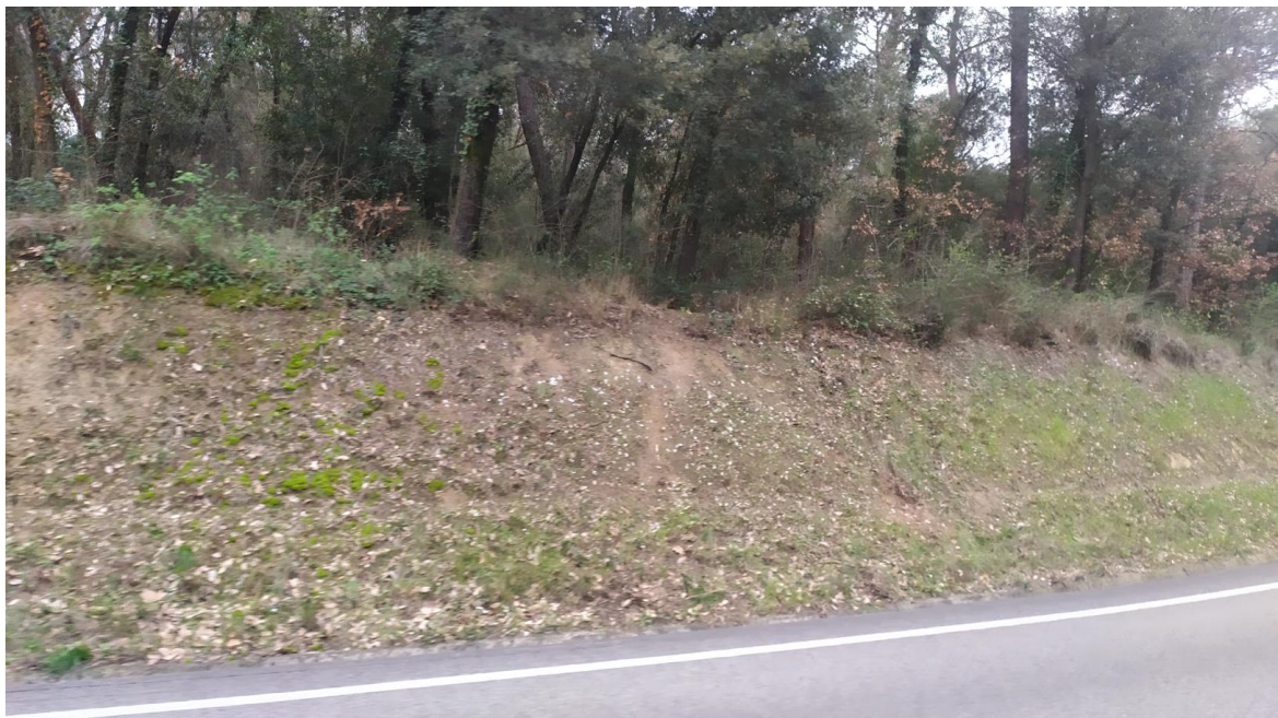
Foto 1. Talussos de la carretera C-155.
