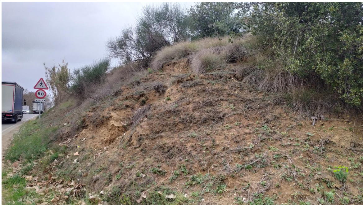
Foto 11. Esllavissada (M1) a la ronda dels Pinetons
